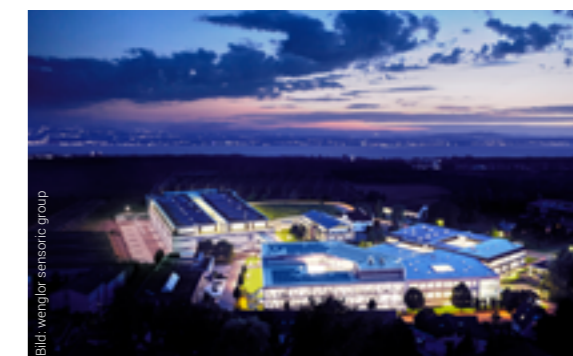
Bild: wenglor sensoric group Der Hauptstandort der wenglor sensoric group am Bodensee
